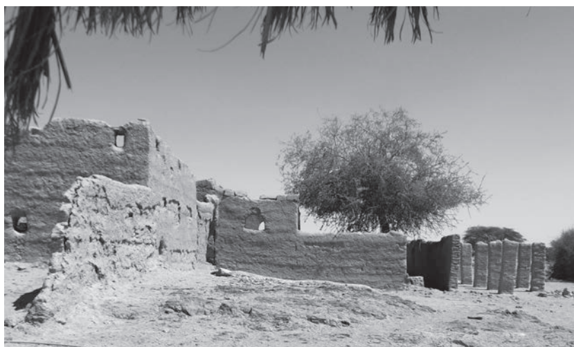
Abb. 1: Ruine eines großzügigen Gästehauses in der Siedlung Ghazali (Foto: D. Eigner).
