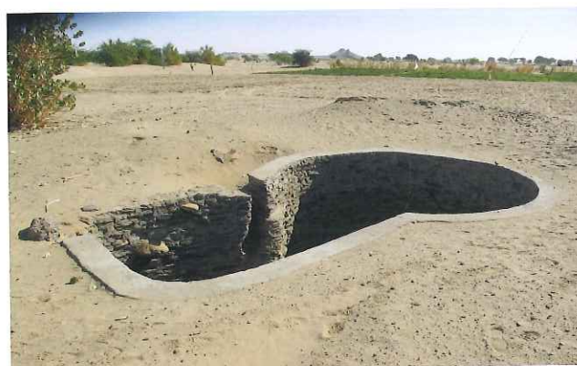
Abb. 4: Ein Brunnen mit gemauertem Oberbau in der Oase von Umm Ruweim. Foto: Tim Karberg
