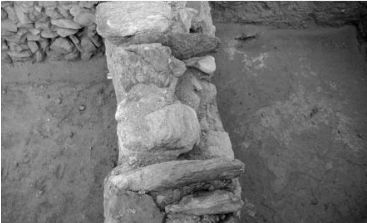
Abb. 11: Durchgangssituation zwischen den Räumen/Schnitten 09 und 15 (Foto: Laurin Stöckert).
